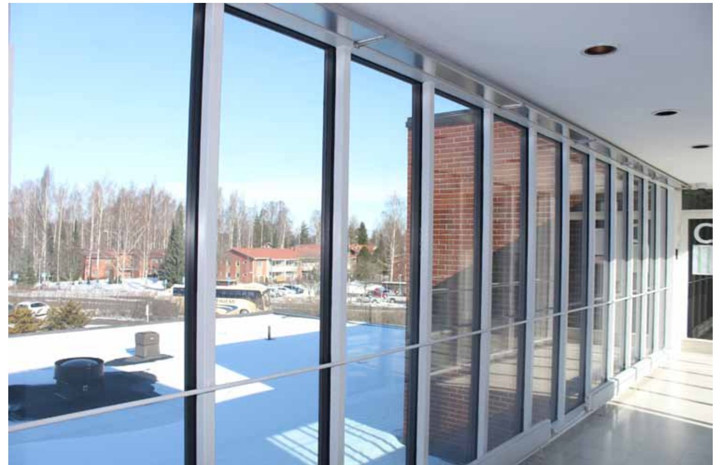
Lounaisen ja koillisen rakennusiiven yhdistää valoisa yhdyskäytävä, jossa sijaitsee myös rakennuksen pääportaikko.
