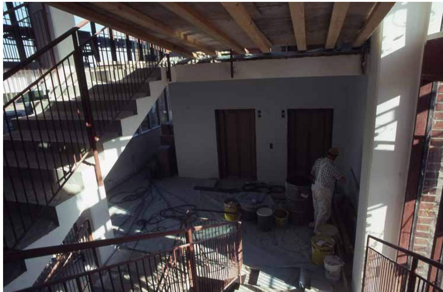
Rakennusaikainen valokuva pääportaikon maalauksesta. Teräskaiteiden punainen väri on pohjamaalia. (Kuva 59.2)
