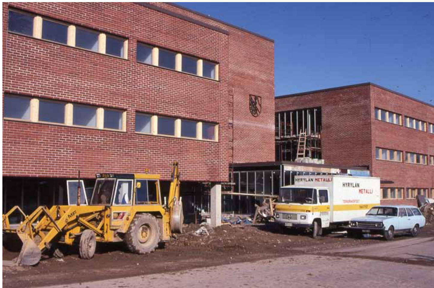
Rakennusaikainen valokuva vuodelta 1980. Nauhaikkunoiden materiaali on lakattua puuta. (Kuva 43.1)
