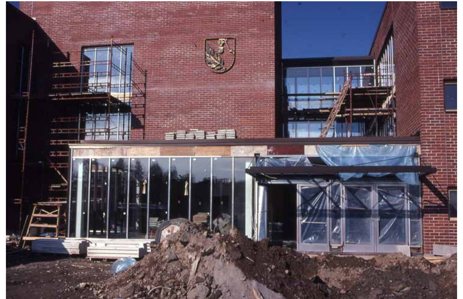
Rakennusaikainen valokuva pääsisäänkäynnistä vuodelta 1980. (Kuva 42.1.)
