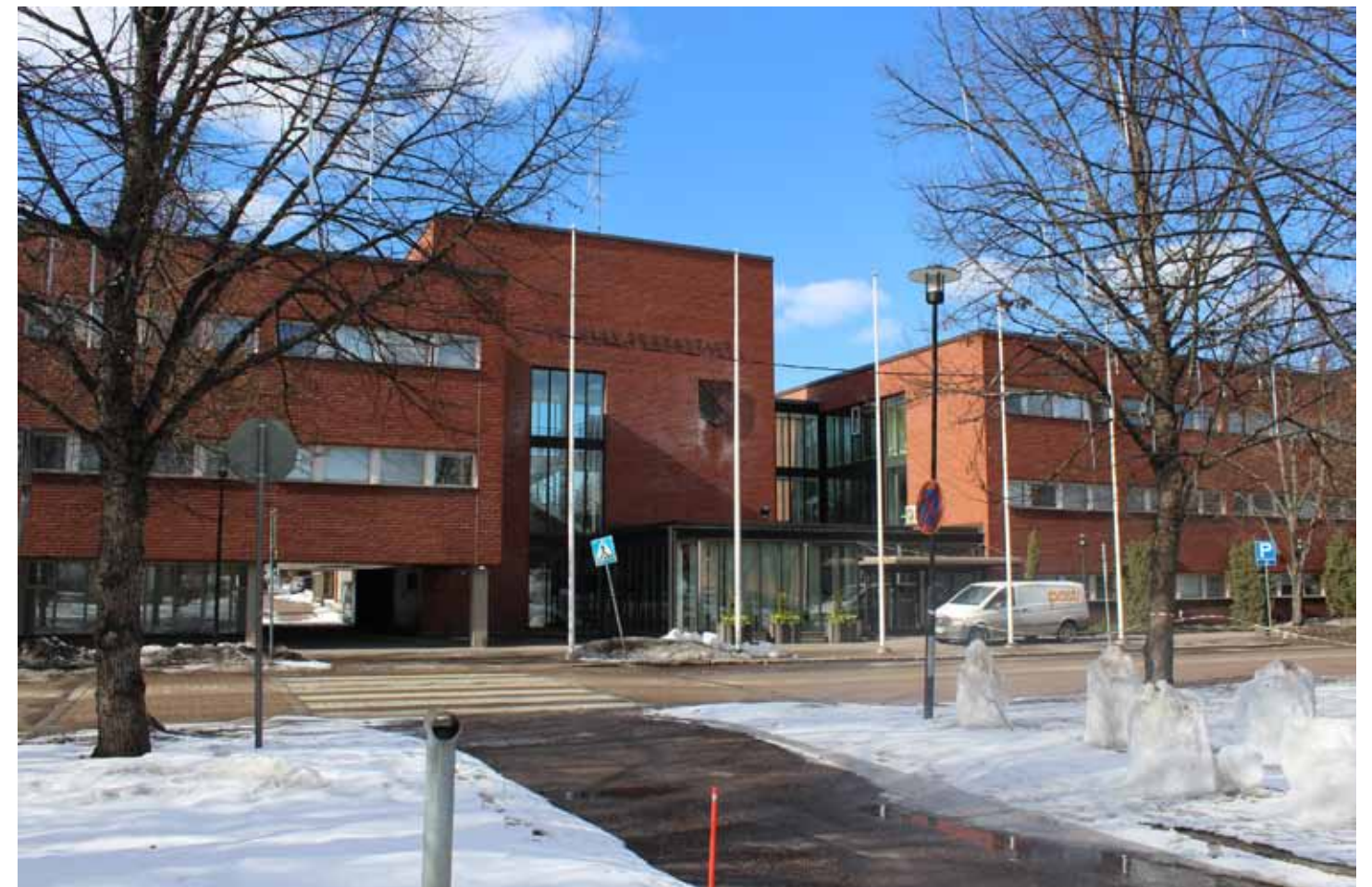
Näkymä kävelyreitiltä kohti kunnantaloa maaliskuussa 2018. Nauhaikkunat ovat maalattu valkoisiksi.
