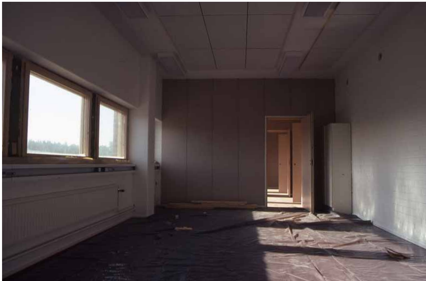
Rakennusaikainen valokuva osastopäällikön työhuoneesta. Viisi ikkuna ja sisäovi osastosihteerin huoneeseen. (Kuva 43.2)
