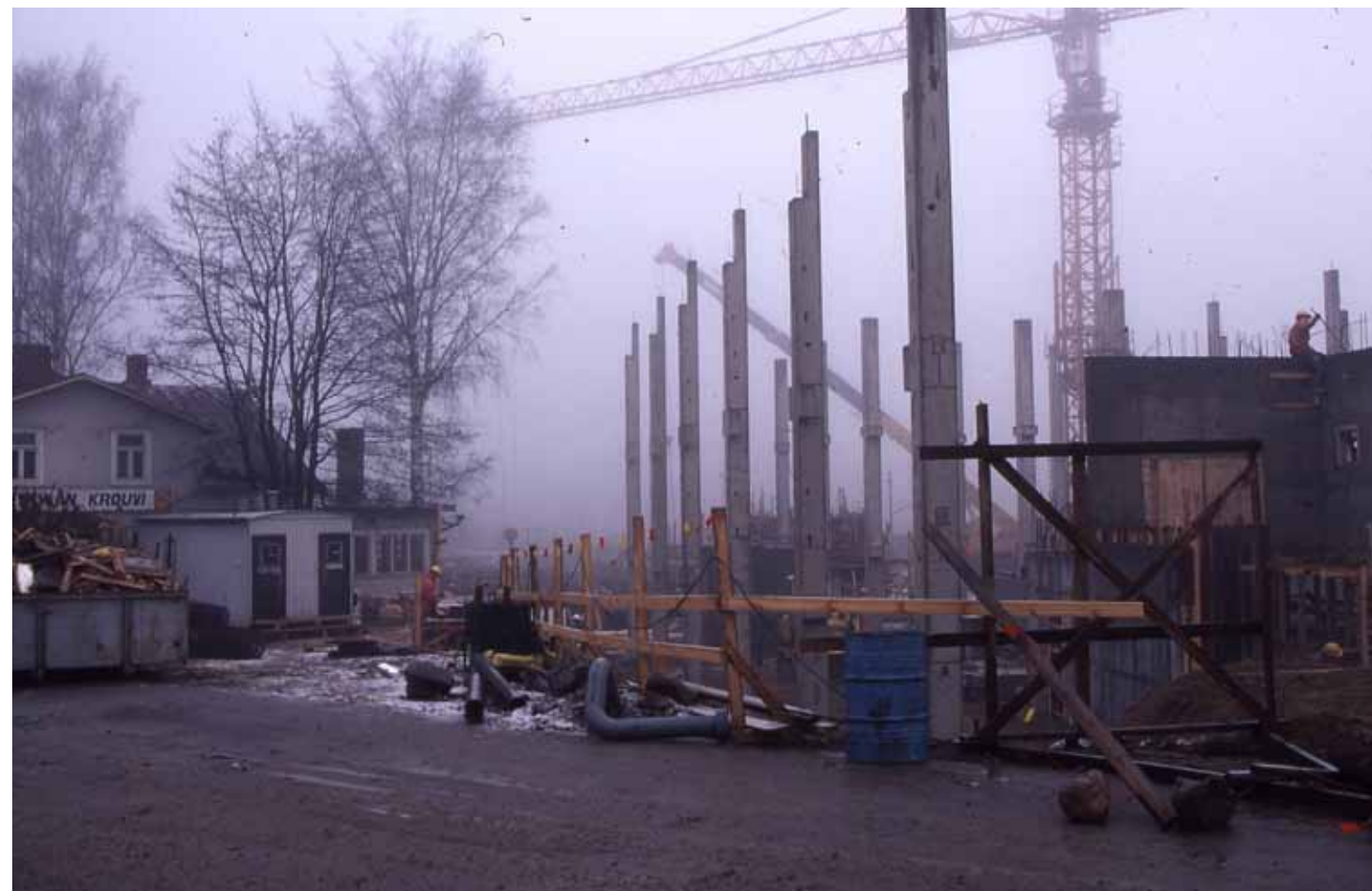
Rakennusaikainen valokuva, jossa runkopilarit ovat pystytetty. (Kuva 29.1)
