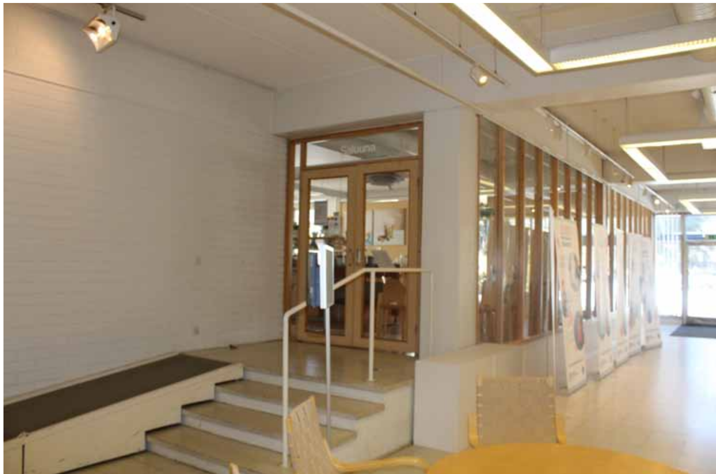
Ravintolasalin lattiapinta on muuta kerrosta korkeammalla. Ramppi on lisätty jälkikäteen.
