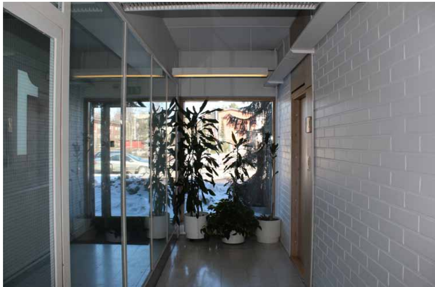
Ensimmäisen kerroksen käytävän lattiamateriaali on vaalea mosaiikkibetonilaatta aulatilojen mukaisesti.
