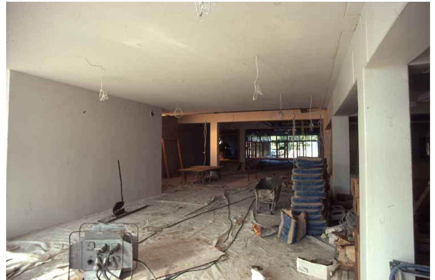
Rakennusaikainen valokuva pääaulasta, vasemmalla hissien takaseinä. (Kuva 58.2)
