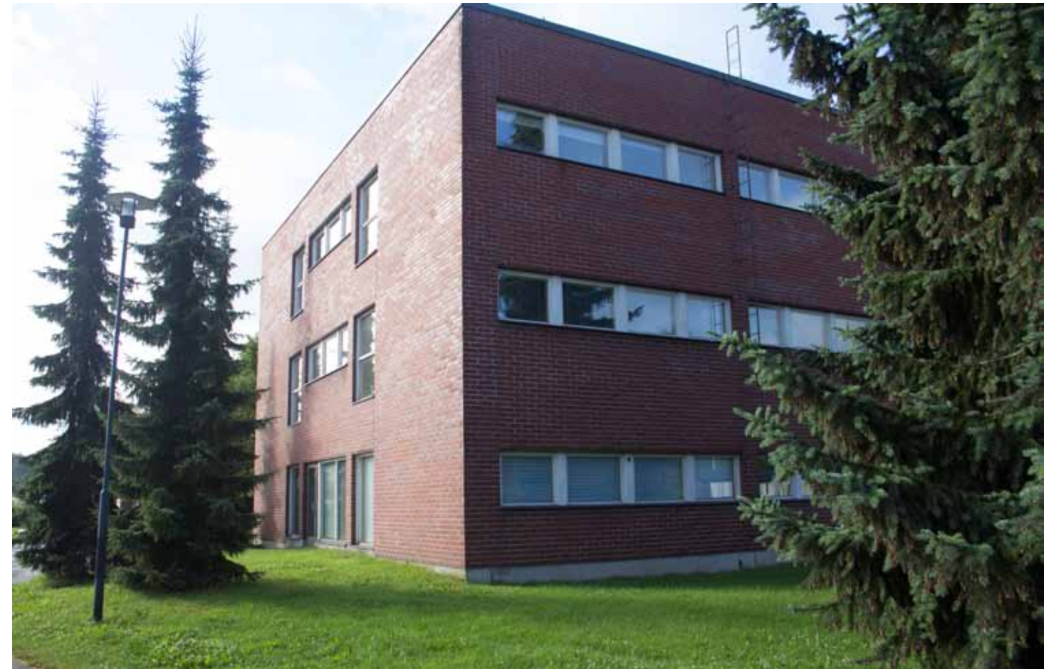
Julkisivu koilliseen. (Kuva 28.1)
