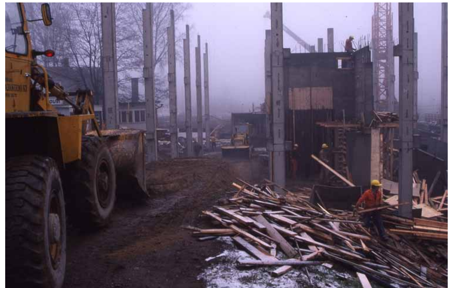
Rakennusaikainen valokuva, josta näkyy kellarikerroksen tasoero toimistosiipeen verrattuna. (Kuva 29.2)
